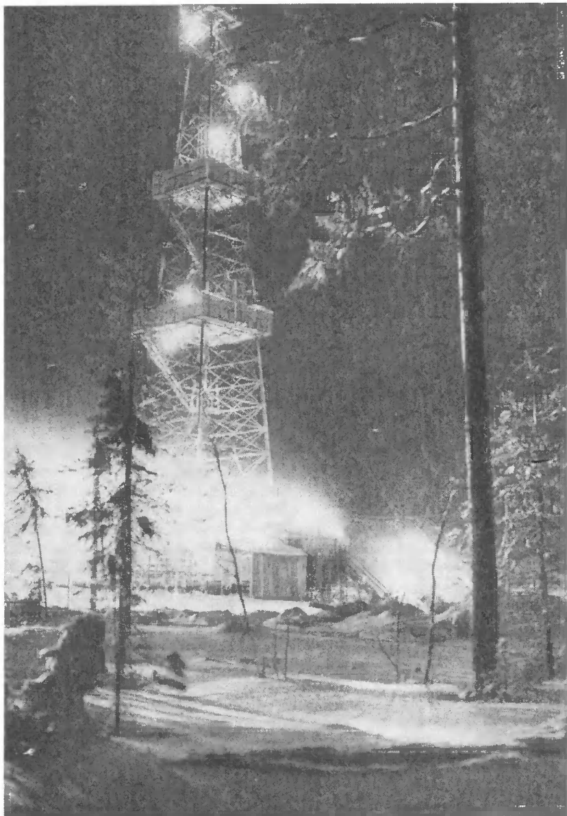
Вуктыл. Бурится глубокая эксплуатационная скважина на вновь открытом месторождении.
